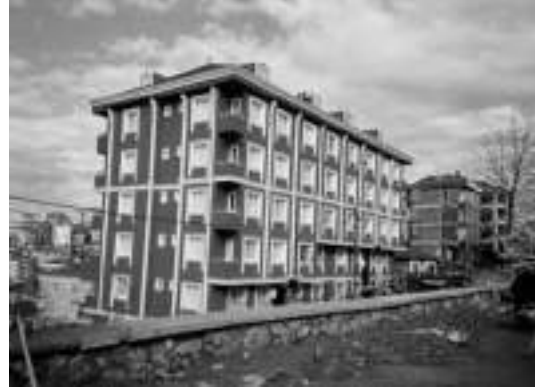
K, 14: Yeni yapılan apartman.
